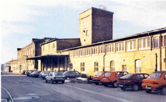
Der HefeHof vor den Sanierungsarbeiten...
